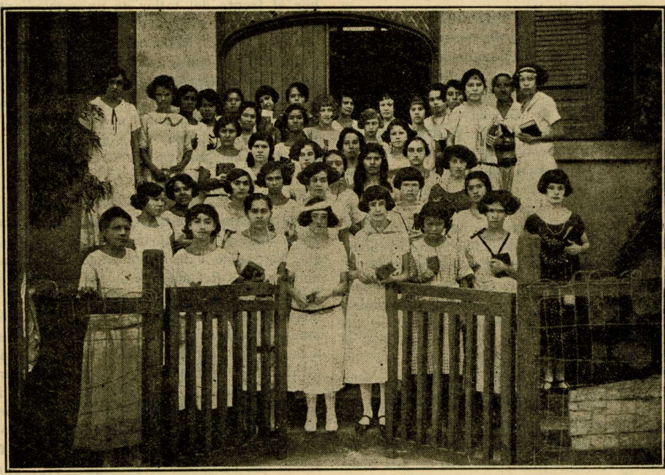
ESCUELA BÍBLICA DE LA IGLESIA BAUTISTA DE CAGUAS.
